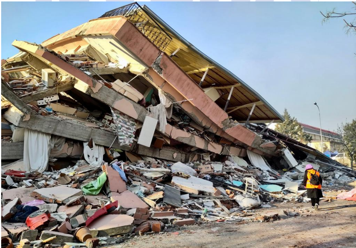
Een van de vele ingestorte gebouwen in het Turkse Kahramanmaraş. Foto: Annemieke Boendermaker
